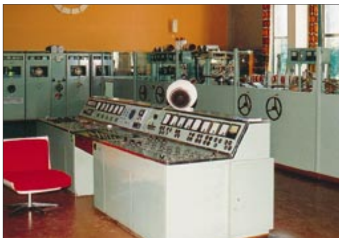
Blick in den Sendesaal mit dem Bedienpult im Vordergrund; die Autolenkräder dienen der Abstimmung von Variometer sowie Plattenkondensatoren.
