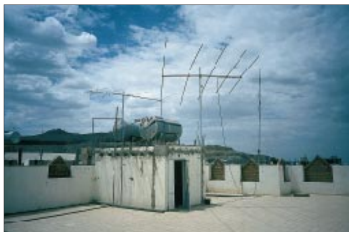
Ein Blick auf das Flachdach und die Antennen von 7O1YGF: sichtbar die 6-m-Yagi, LP5 und R7, nicht zu erkennen sind die zweite LP5 auf dem Versa-Tower und der Doppeldipol für 40 und 80 m.
