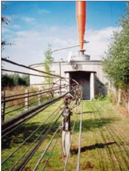
Koaxialleitung einmal anders ... Im Hintergrund der Fuß des auf einem Isolator lastenden 110-t-Mastes
